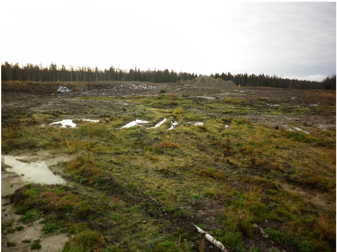
Рисунок 2 – Вид на площадку строительства полигона ТБО
