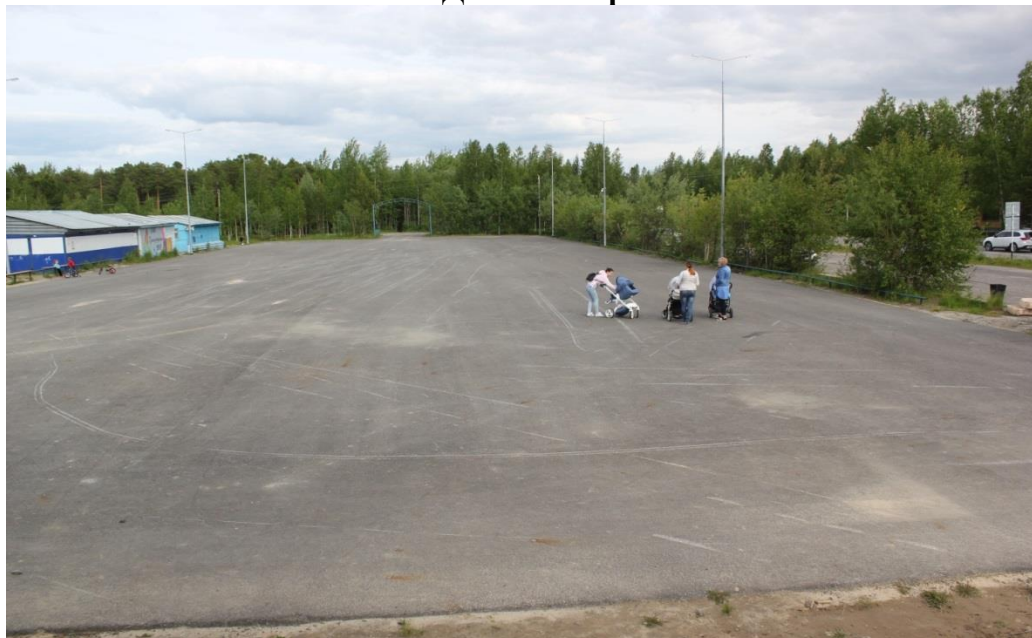
Фото ДО начала работ
