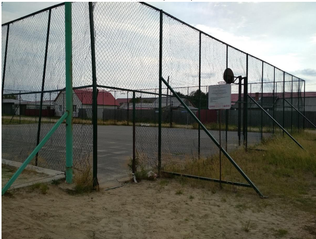
Фотоотчет по баскетбольной площадке по ул. Югорская 5в
